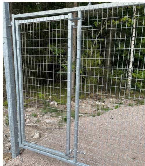
Montage av gånggrind i fordonsgrind
