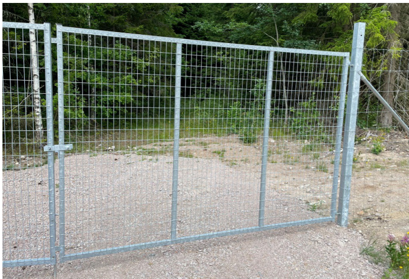
Montage av fordonsgrind, gjutna stolpar och infästning . Max avstånd mellan grindarna för vara 50mm.
