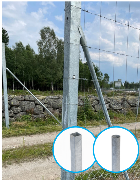
Montage av ändstolpe, med stag
