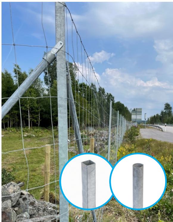
Montage av hörnstolpe med stag i hörn. Montera nät på utsidan av stolpen.
