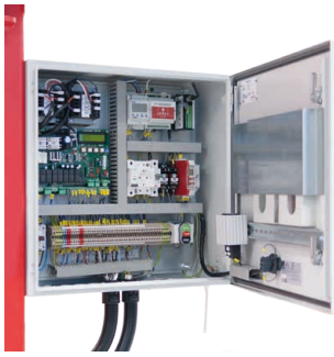
Armoire de contrôle
